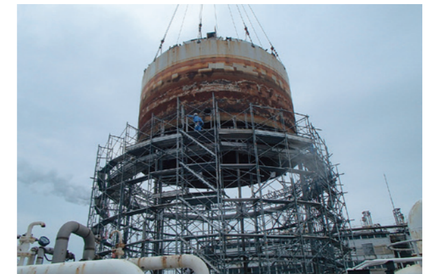
ガス槽更新工事水槽 [13,560 φ ×6,870 H ]
