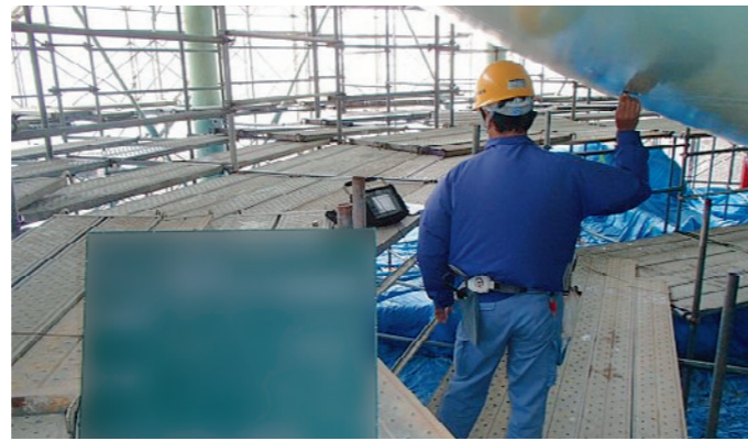
外部UT検査 パルス反射法
