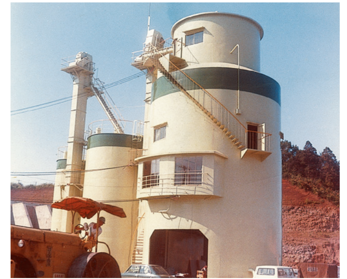
バッチャープラント (コンクリートミキシング) [2,500 m 3 3基]
