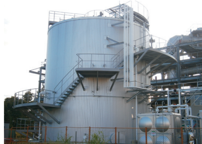
消化タンク 製作据付及び配管 [200 φ ~40 φ ]
