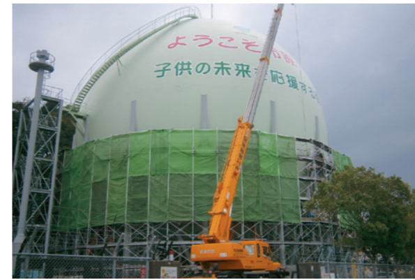
耐震補強プレス交換
