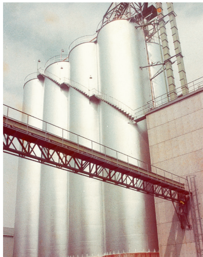
2,400 ton 穀物集合サイロ(キーストン仕切り)11基
