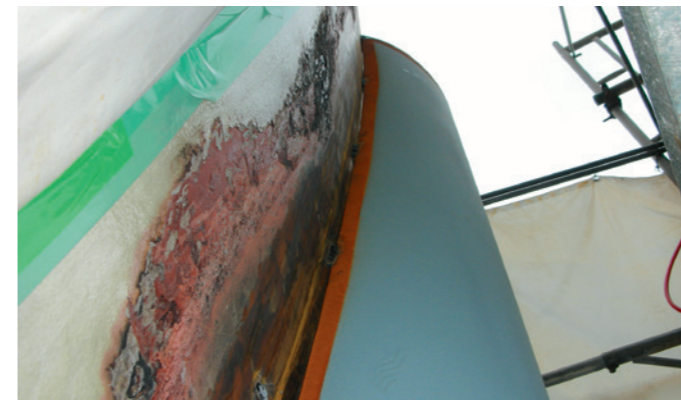
球形ホルダー基柱交換工事
