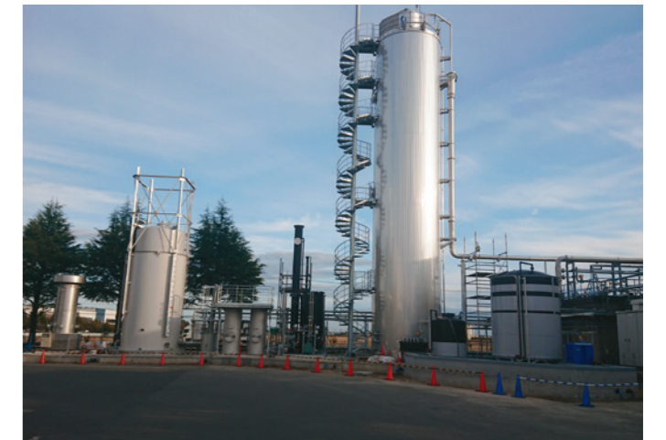
ICリアクター [4,000 φ ×20,000 H ] 乾式脱硫塔 [1,000 φ ×2,700 H ] ガスシールタンク [1,000 φ ×1,300 H ] 有水式ガスホルダー [3,300 φ ×5,550 H ]
