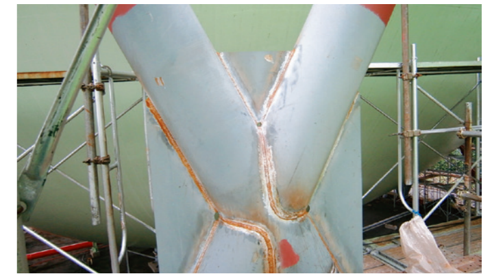
球形ホルダーブレース交換工事
