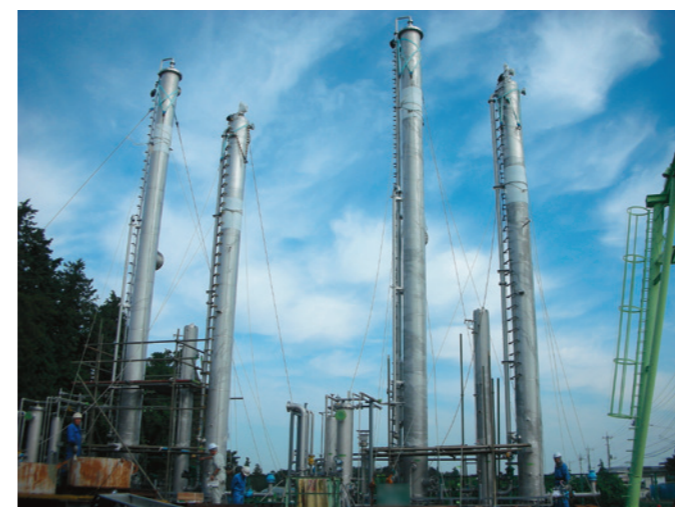
消化ガス精製装置 [2,800 φ ×5,950 φ ×11,800 H 2式] 吸収塔 [600 φ ×11,737 H 他]
