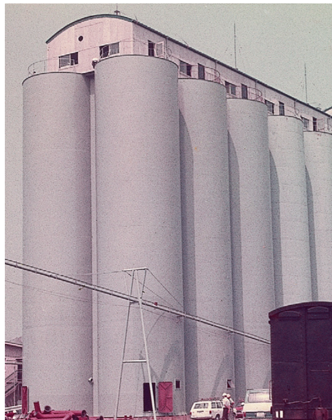
800 ton 集合サイロ 12基
