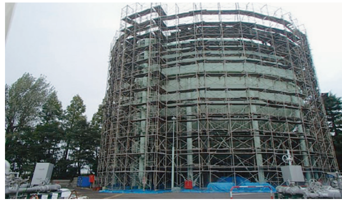
外部足場組立
