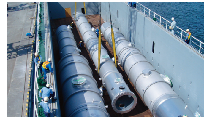
溶剤回収塔 [1,800 φ ×26,490 H 他3基]
