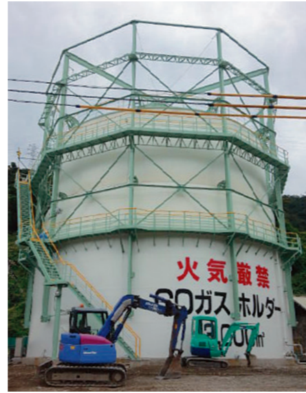
3,000m 3 複槽式 有水ガスホルダー 水槽[19,200 φ ×6,900 H ] ガス槽[18,500 φ ×17,800 H ]
