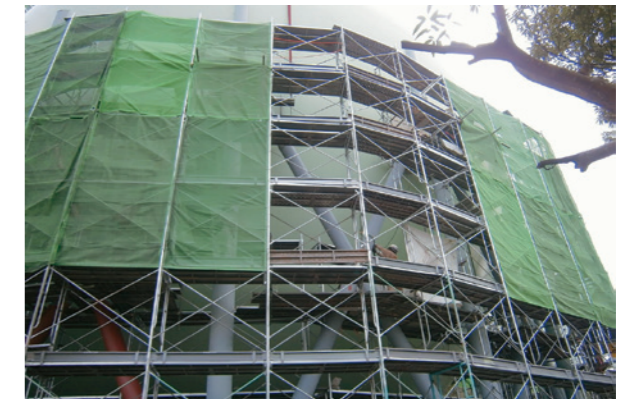
耐震補強プレス交換
