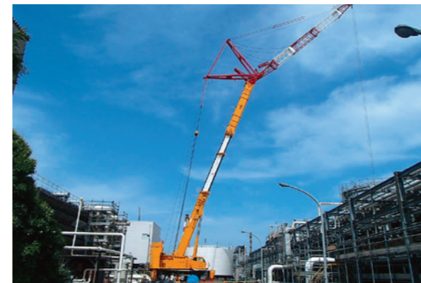
国内最大550 ton クレーン
