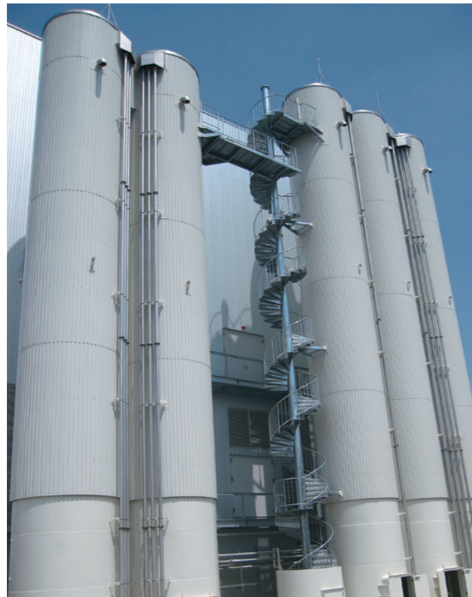
小麦粉サイロ[3,200 φ ×27,416 H 75 ton 3基/60 ton 2基]
