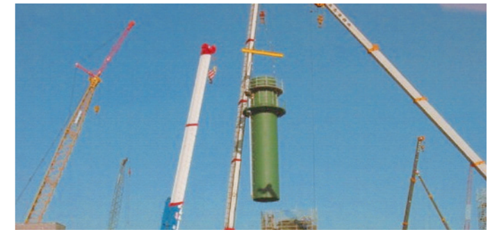
煙突組立作業
