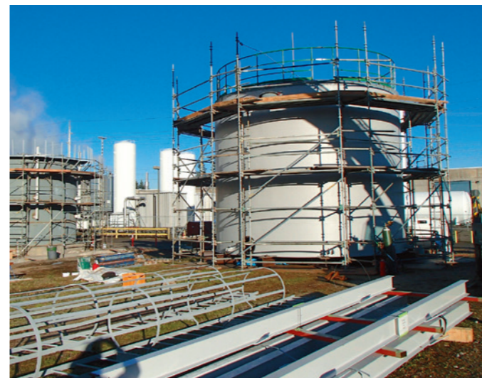
アメリカ現地据付 200m 3 有水式ガスホルダー (陸組)
